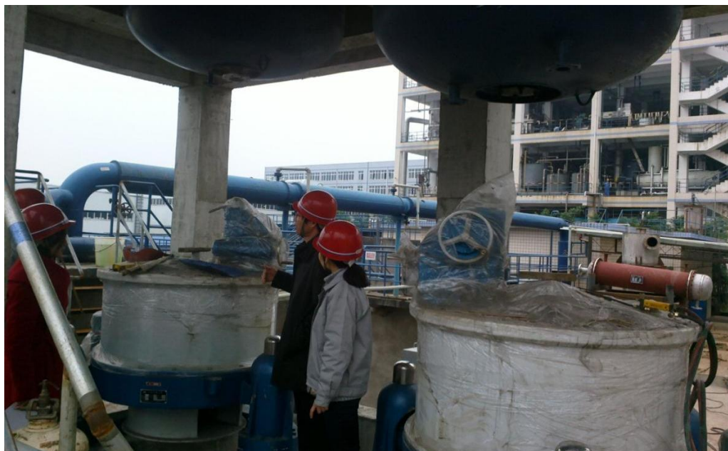
图 20 羧甲基纤维素锂 CMCLi 工程化试制现场
